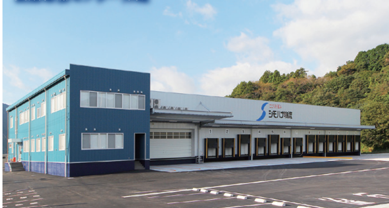
愛媛物流センター外観
